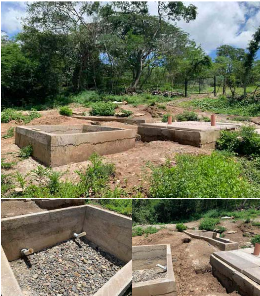
Condiciones actuales de la construcción de la PTAR San Lorenzo.
