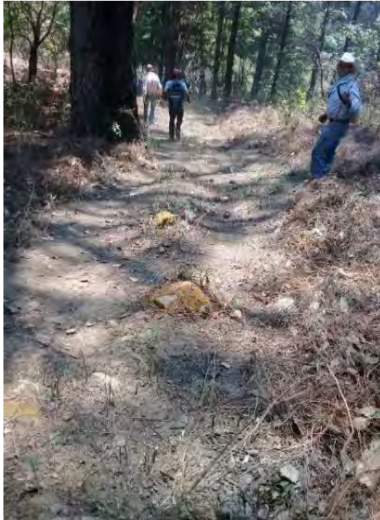
Labores de relimpia de brecha cortafuego
