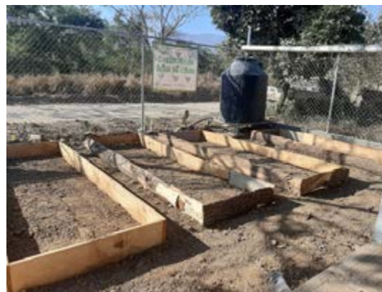
Instalación de camas para huerto urbano.
