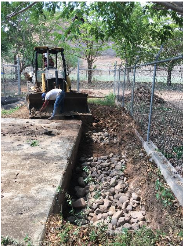
Construcción de la fosa de secado de lodos en la PTAR de La Labor, Mpio de Ejutla.
