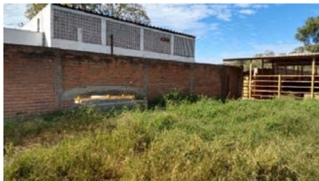
Espacio disponible para instalación de sistema biodigestor
