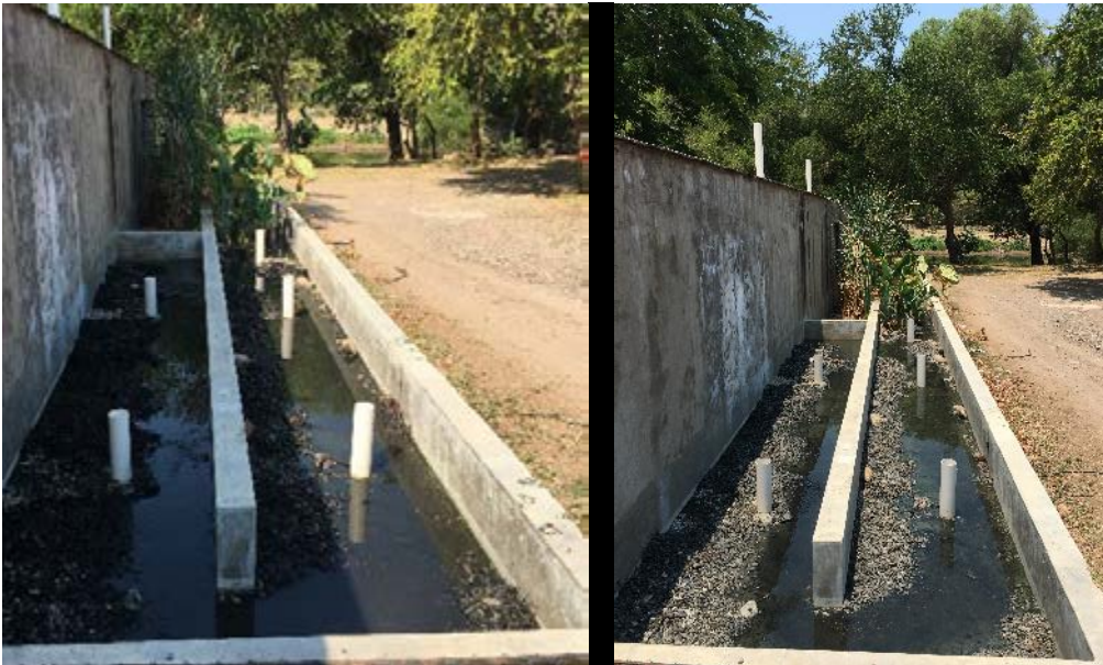
Comparativa del antes y después de las labores de mantenimiento en la PTAR de La Laja, El Grullo. Estas labores ayudaron a mejorar el flujo de agua en el sistema.
