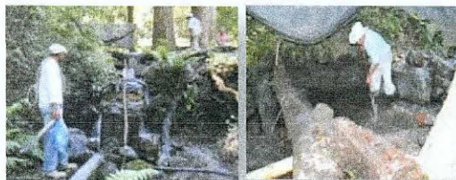
Imagen 1. Visita al Manantial "El Nevado" de donde se abastece la Cabecera Municipal de Zapotitlán de Vadillo.
