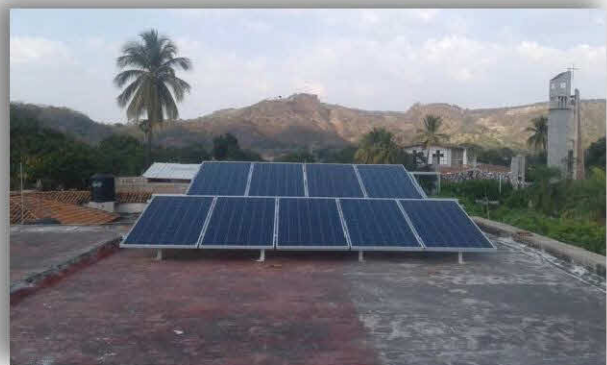
Imagen 16. Instalación de paneles en el ayuntamiento de Tuxcacuesco.
