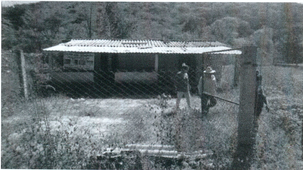
Imagen 4.- Instalaciones en las que se pretende implementar el proyecto una vez realizadas las actividades de rehabilitación y equipamiento.
