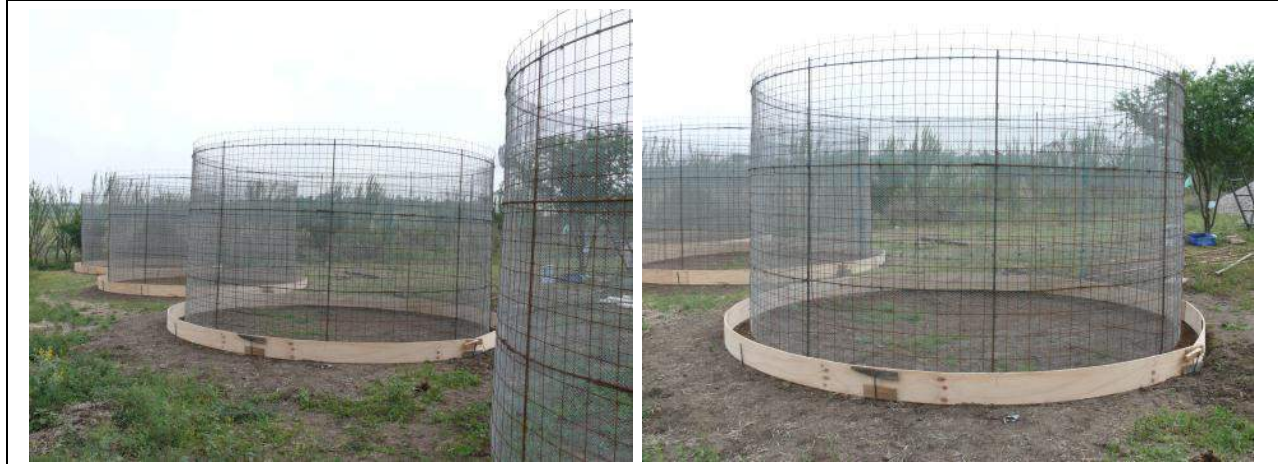
Proceso del colado de la base del tanque de ferrocemento con la asesoría de Campo A. C. con el productor Raúl de la Cruz
