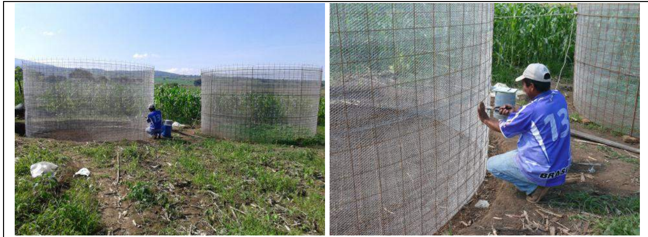
Estructuras preparadas para colar su base
