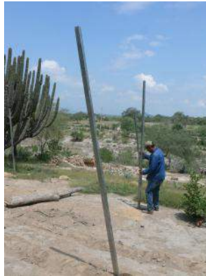
Proceso de colocación de postes que darán soporte al invernadero. Inicio de construcción del invernadero.
