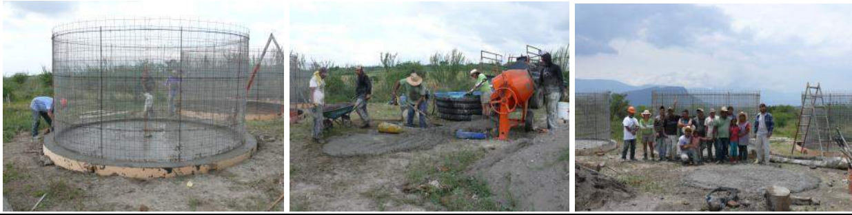
Proceso del colado de la base del tanque de ferrocemento con la asesoría de Campo A. C. con el productor Leobardo de la Cruz
