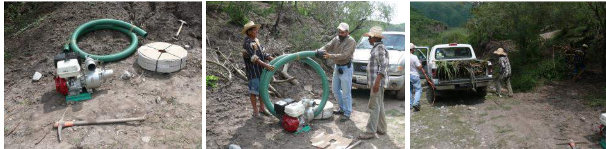
Selección y preparación del sitio para la colocación de la maralfalfa
