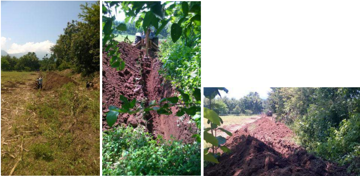
Colocación de tubería para el traslado de agua para riego
