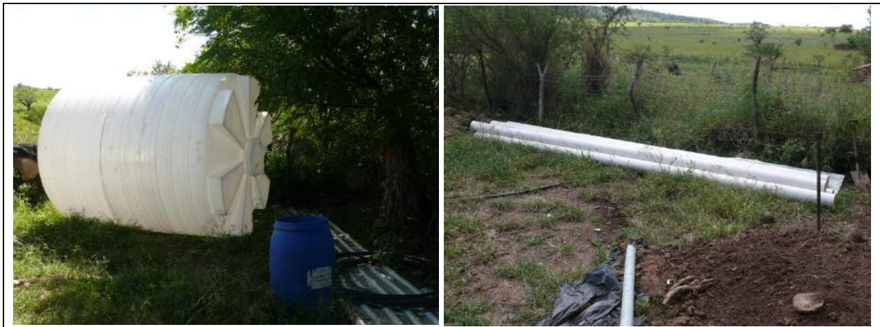
Excavación de pozo para sentar la cisterna
