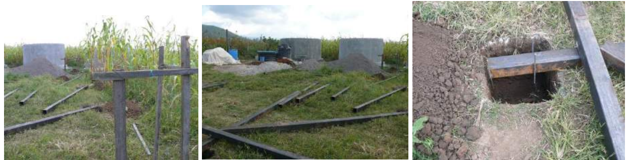
Armado de estructuras para soporte de techo de lámina para la captación de agua de lluvia
