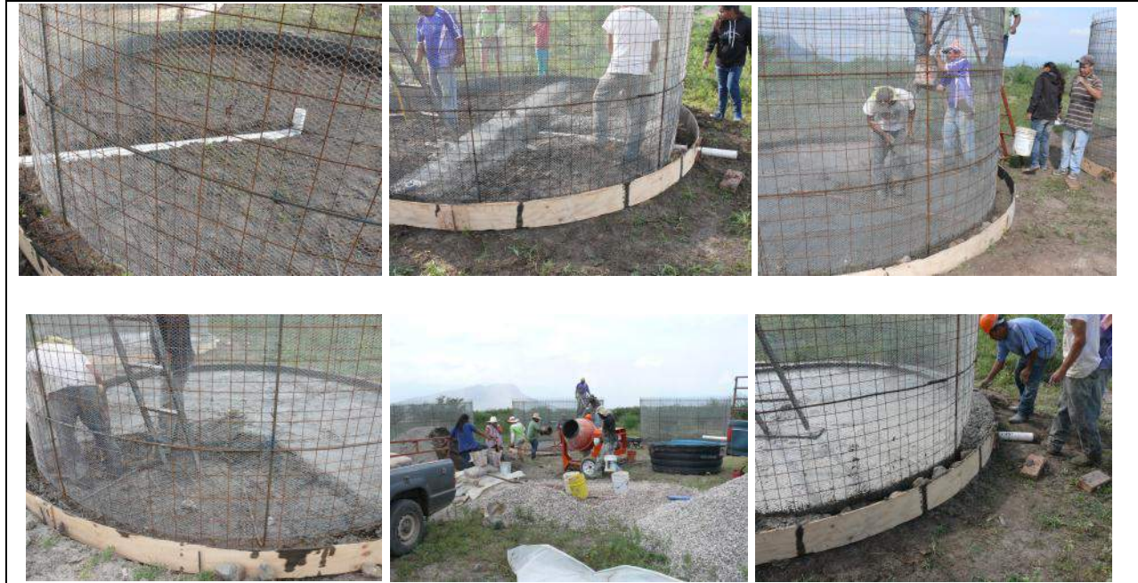
Proceso del colado de la base del tanque de ferrocemento con la asesoría de Campo A. C. con el productor Raúl de la Cruz
