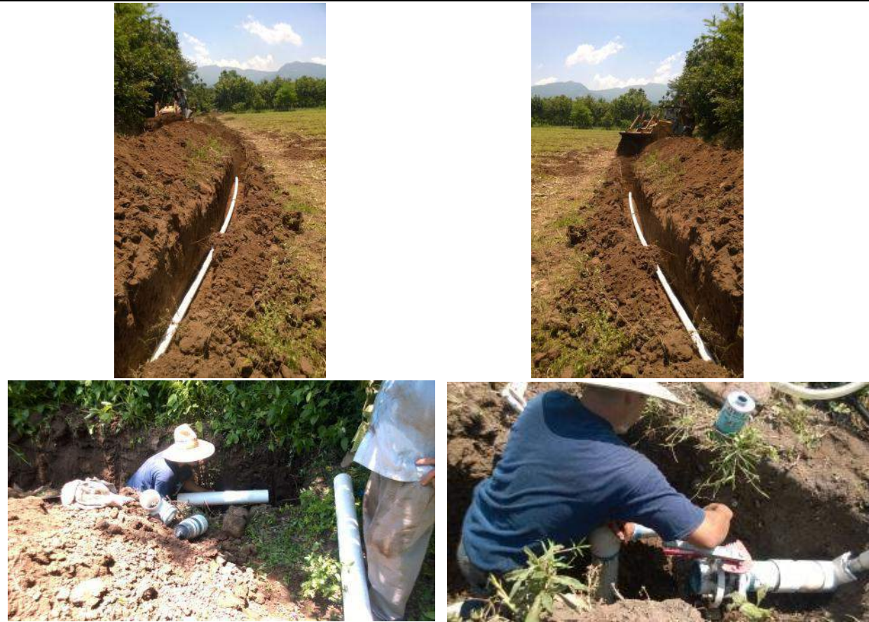
Colocación de tubería para el traslado de agua para riego
