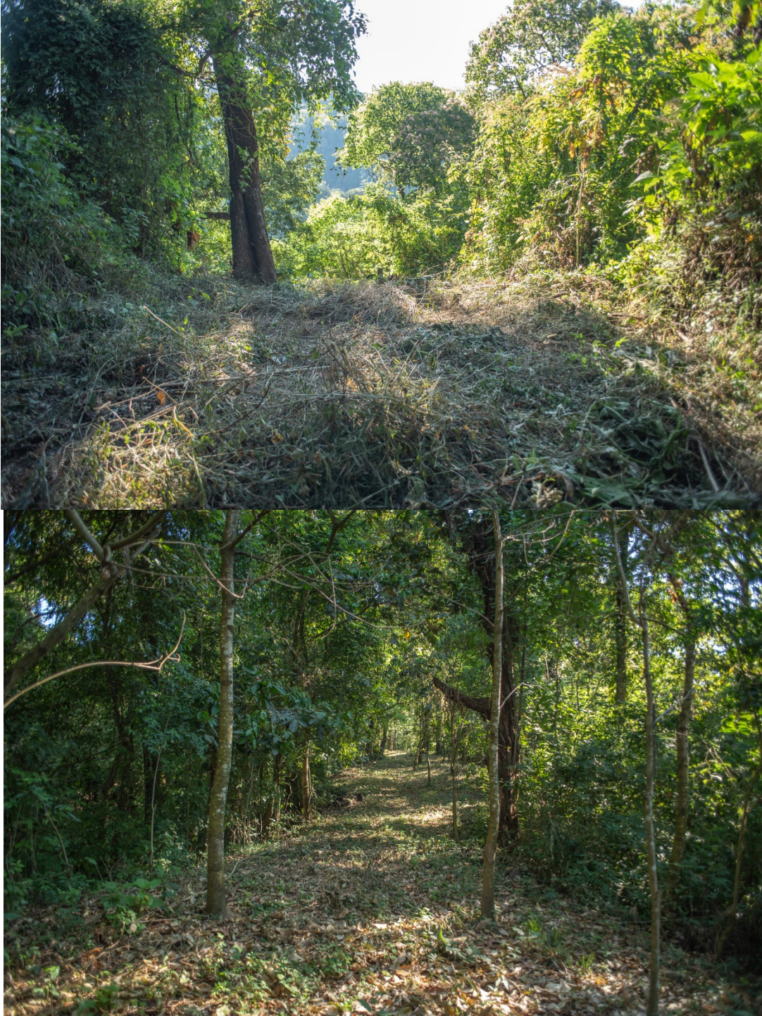
Rehabilitación de brechas cortafuego y protección de suelos en ejido San José del Carmen
