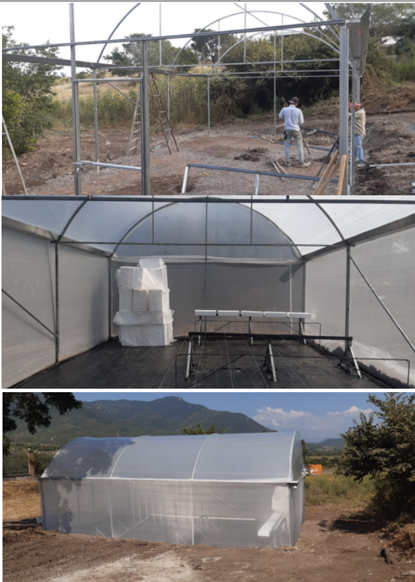
Instalación de invernadero en el sitio demostrativo del Municipio del El Limón
