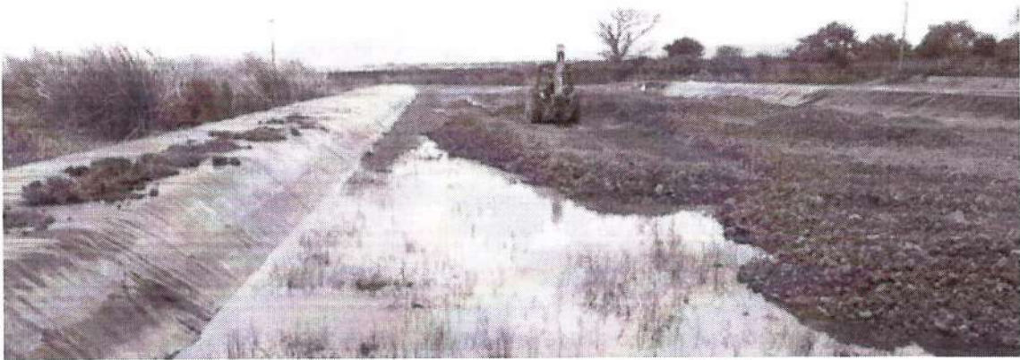
labores de rehabilitación Labores de dispersión y nivelación. Julio 2023
