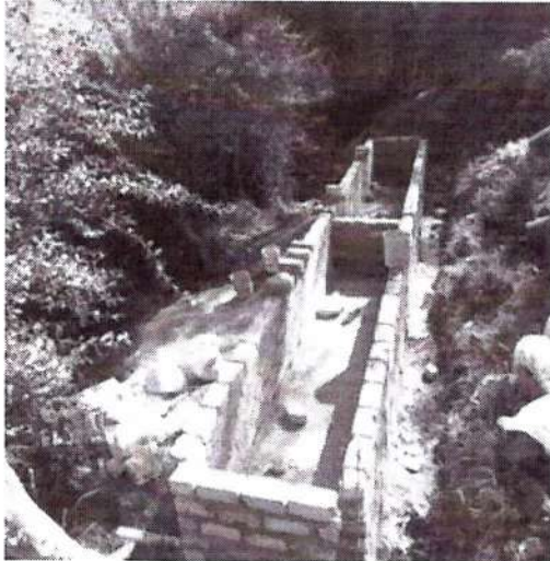
Biodigestor en construcción
