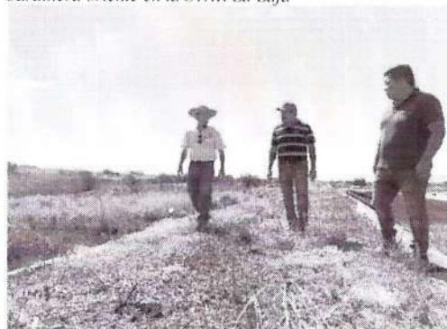
Recorrido por la STAR de Copala, con personal de obra pública del Ayuntamiento de Tohman.
