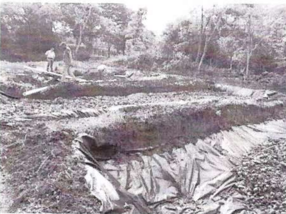
Construcción de los humedales en la STAR de San Lorenzo, Mpio. Ejutla.
