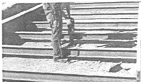
Detalle del procedimiento de nivelación
